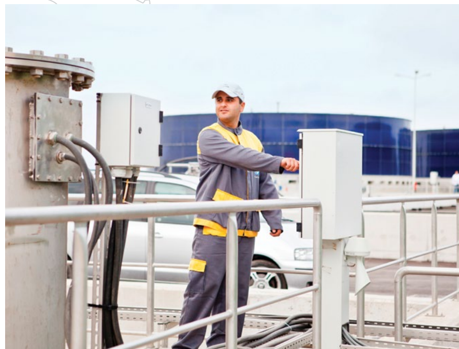
Verbesserung der Wasserinfrastruktur in Batumi © KfW-Bildarchiv/ Rendel Freude
